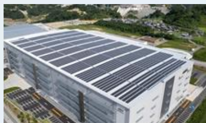
物流倉庫 屋上太陽光
